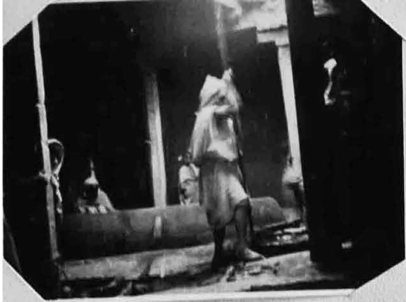
Près la mosquée. Le tirant d'eau pour les ablutions coraniques.
