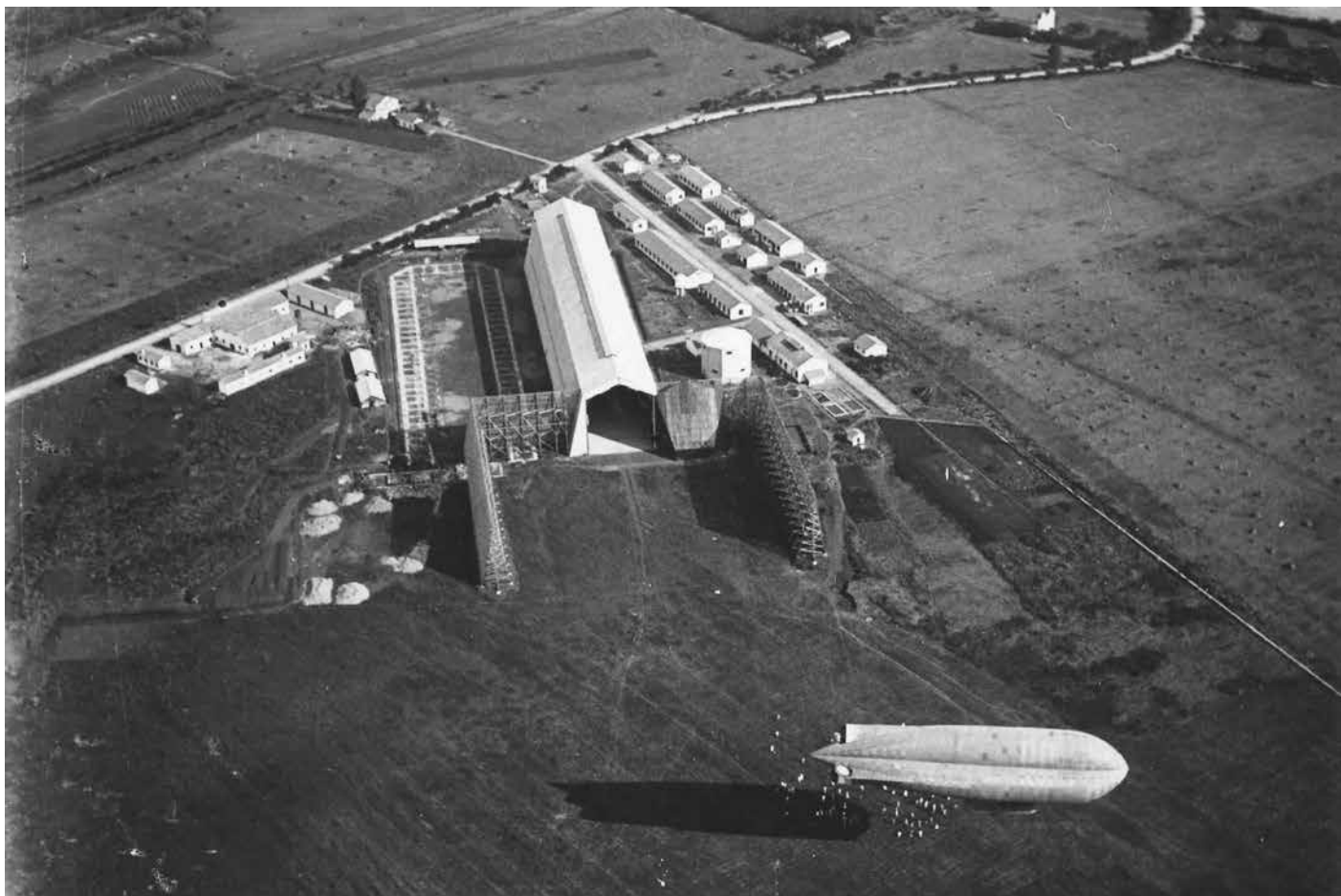
▲ Le centre de Baraki avec un dirigeable à l'extérieur. On remarque les avants-ports destinés à protéger le dirigeable du vent pendant l'entrée et la sortie du hangar
