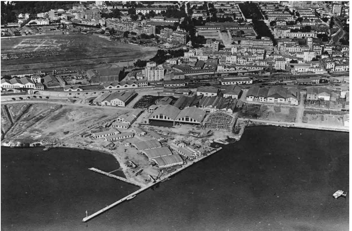
▲ Le centre d'Aviation Maritime d'Alger et ses hangars en construction, devant le Champ-de-Manœuvre
